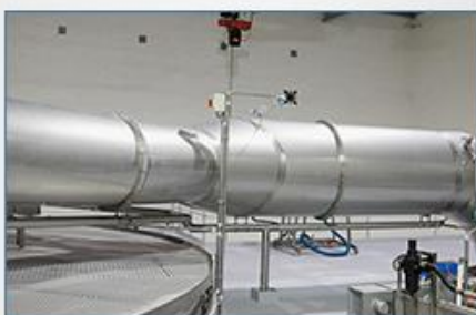
地下管道监控
