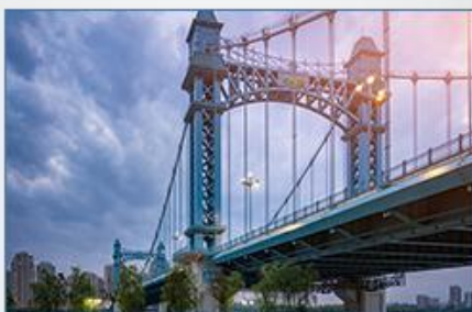
桥梁建筑物监测
