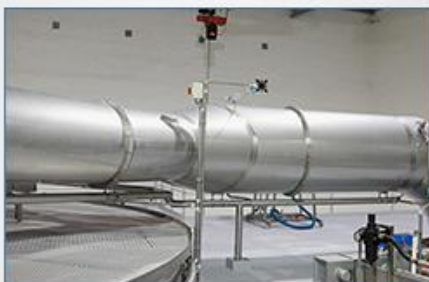
地下管道监控
